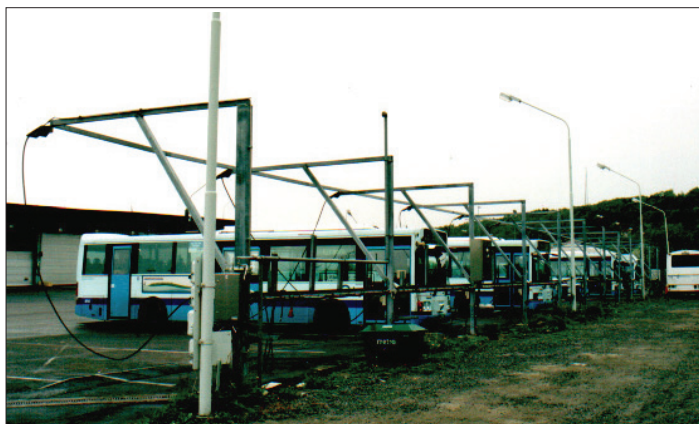
Rys. 3.7. Stanowiska powolnego tankowania autobusów CNG w Göteborgu
