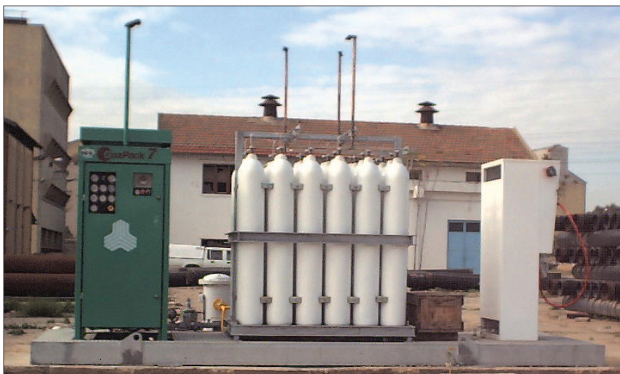
Rys. 3.9. Przykład niewielkiej stacji tankowania firmy CompAir
